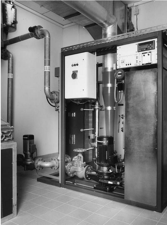
**Figure 2.3** *Telefunken dummy load (Courtesy Telefunken Sendertechnik GmbH)*
