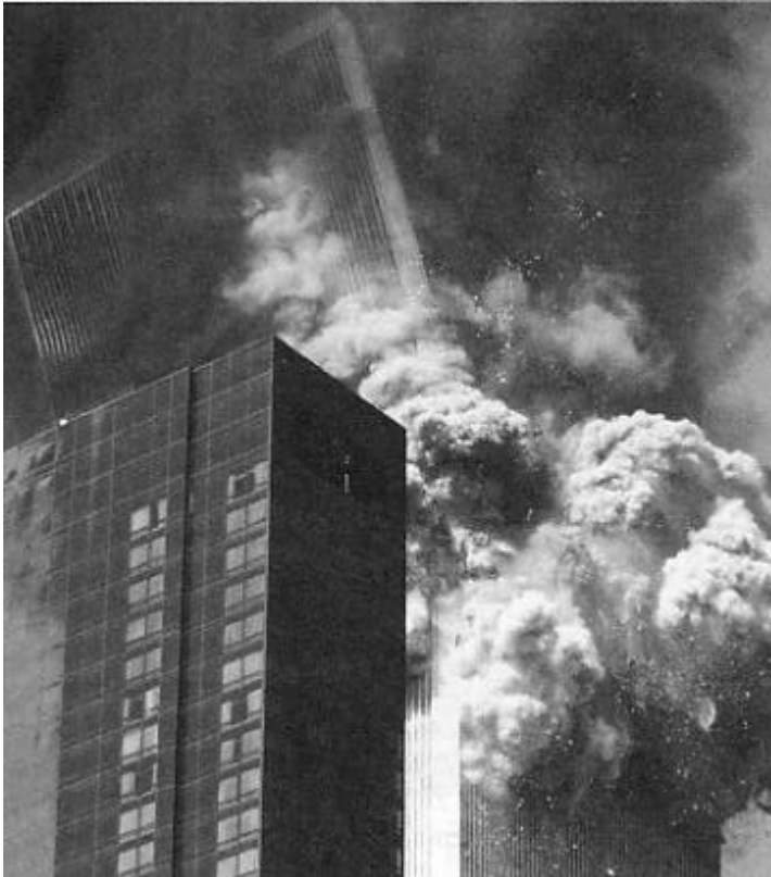
Die Stockwerke oberhalb der Einschlagstelle des Südturms kippen und brechen auseinander.
