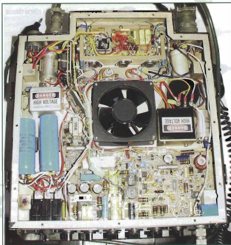
Foto 5: Vista interna dal basso dell'alimentatore RF-2360
