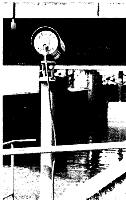
Bild 3 Feste Kamera für Schleusenkammer und Tor der Reiherstiegsschleuse. Die Brücken behindern die Sicht in den Vorhafen.
